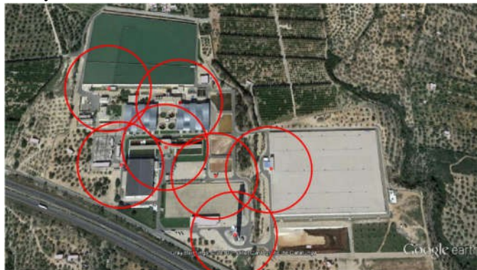
Obr.20. Consorci Aigües Tarragona, Čistička odpadových vôd
