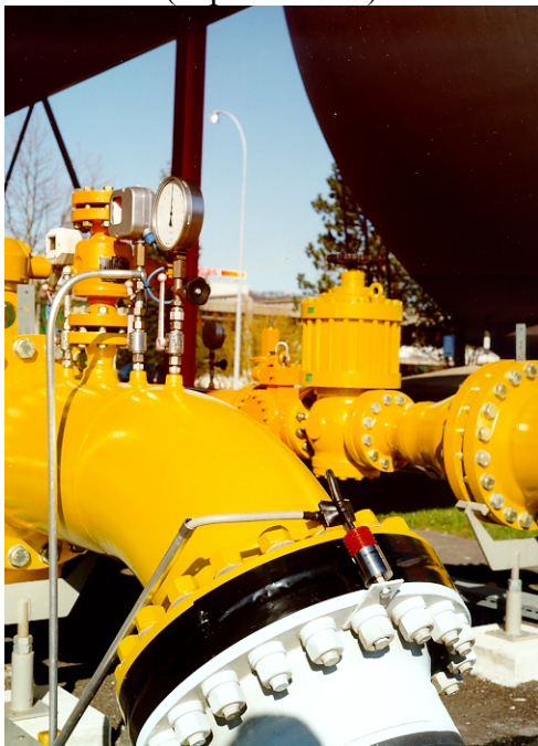
obr. 13 Protiblesková ochrana izolačnej príruby
